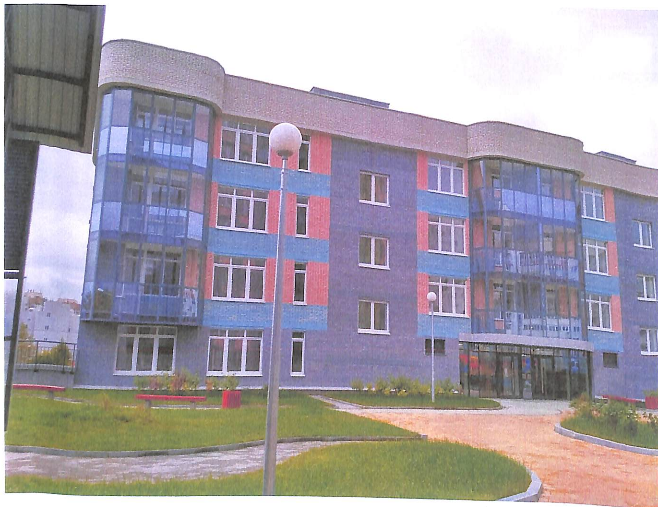
Дворовой фасад. Боковой фасад 2.
